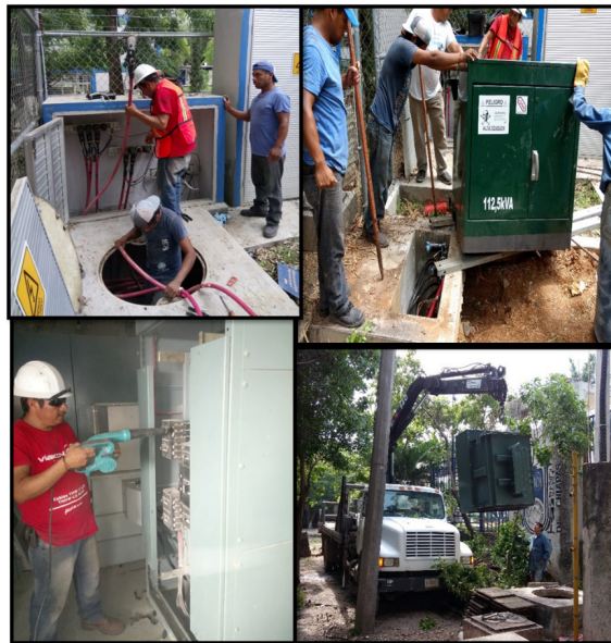
Sustitución de transformadores.
